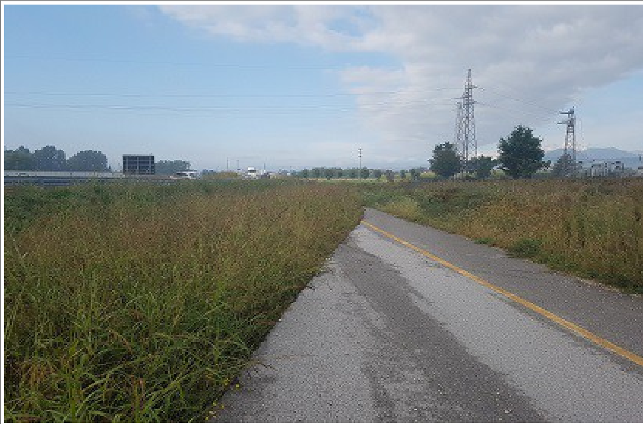
Foto 3.7 – dettagli lato sud, e vista su elettrodotto
